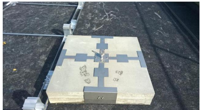
Abb. 4: "Stonekit" Auflastsystem mit Seilsystem von Gün GmbH ([www.gruen-gmbh.de](http://www.gruen-gmbh.de)) in Kombination mit MSP-FR-EW.
