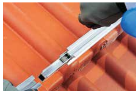
Werkzeuglose Montage des Schienenverbinders ohne Verschraubung.
