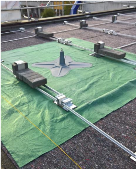
Fig. 5: Système de ligne de vie « Diasafe » en combinaison avec MSP-FR-EW/-S (fournisseur : SOPREMA AG, www.soprema.ch )
