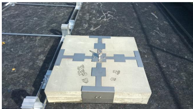
Fig. 4: Système de charge « Stonekit » avec système de cordes de Grün GmbH ( www.gruen-gmbh.de ) en combinaison avec MSP-FR-EW
