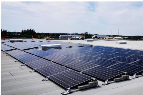
Das PV-Montagesystem **Flachdach Süd MSP-FR-S** ist ein frei ausrichtbares Montagesystem ohne Dachdurchdringung. Es zeichnet sich durch einen geringen Lastbedarf aus. Die flexibel wählbaren Punktauflagen gewährleisten den Abfluss des Regenwassers in alle Richtungen. Je nach Dichte der Dachdämmung können die Auflageflächen ausgewählt werden, sodass die Dachhaut auch langfristig nicht beschädigt wird. Das Flachdachsystem MSP-FR-S ist weitgehend kompatibel mit dem Flachdachsystem MSP-FR-EW.
