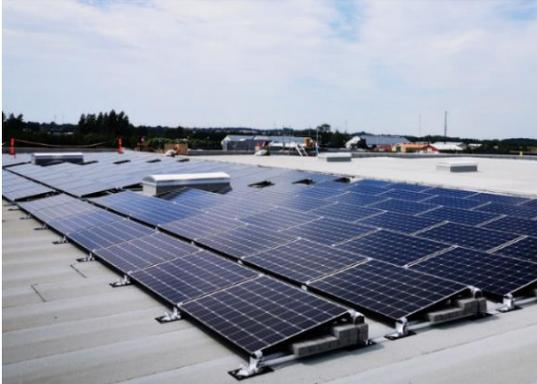
Das PV-Montagesystem **Flachdach Süd MSP-FR-S** ist ein frei ausrichtbares Montagesystem ohne Dachdurchdringung. Es zeichnet sich durch einen geringen Lastbedarf aus. Die flexibel wählbaren Punktauflagen gewährleisten den Abfluss des Regenwassers in alle Richtungen. Je nach Dichte der Dachdämmung können die Auflageflächen ausgewählt werden, sodass die Dachhaut auch langfristig nicht beschädigt wird. Das Flachdachsystem MSP-FR-S ist weitgehend kompatibel mit dem Flachdachsystem MSP-FR-EW.
