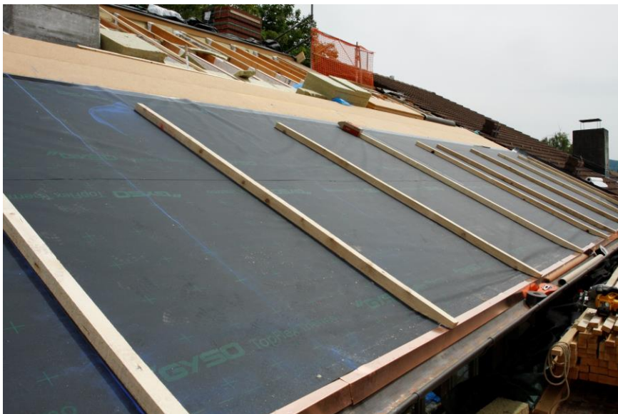
Abbildung 2: Unterdach für erhöhte Beanspruchung - Dachfolie TopFlex Thermo, Firma Gyso AG
