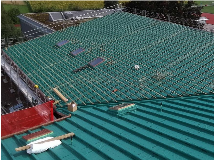
Abbildung 1: Unterdach für ausserordentliche Beanspruchung - Dachfolie Top Weld 520, Firma Gyso AG
