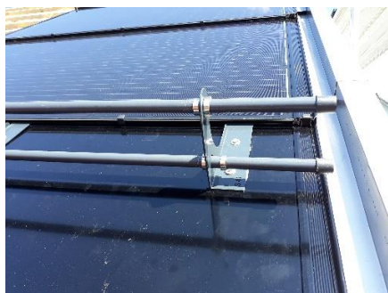
Abb. 5: Traufbereich mit Schneefang auf Blindmodulen
