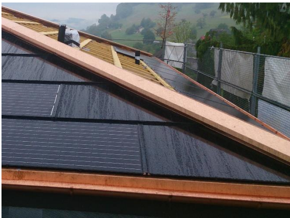
Abb. 1: Abschluss zum Grat eines Walmdaches
