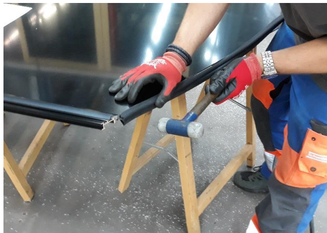
Abb. 13: Aufgestecktes Stahlband als Abschluss der Schnittkante
