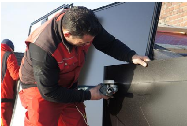
Abb. 10: Zuschnitt Blindmodul auf der Baustelle
