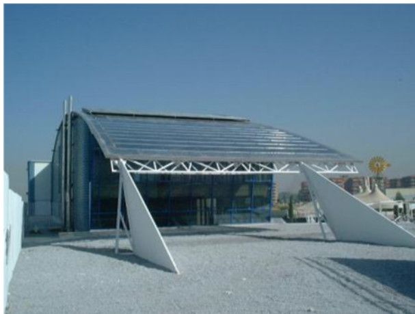
Beispiel eines gewölbten Daches, Bibliothek in Granada (Spanien) mit Metallunterkonstruktion
