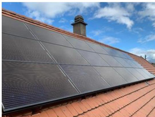
En plus de la gamme d'articles MSP-PR, des **profilés d'insertion** sont disponibles pour le montage des modules PV sans tension. Ils sont fixés aux profilés supports MSP-PR-CH montés verticalement comme deuxième couche avec le connecteur transversal MSP-PR-CC. Les profilés d'insertion peuvent également être rallongés avec le connecteur de profilé. Les modules PV peuvent être protégés contre le déplacement à l'aide d'une cale d'insertion.
