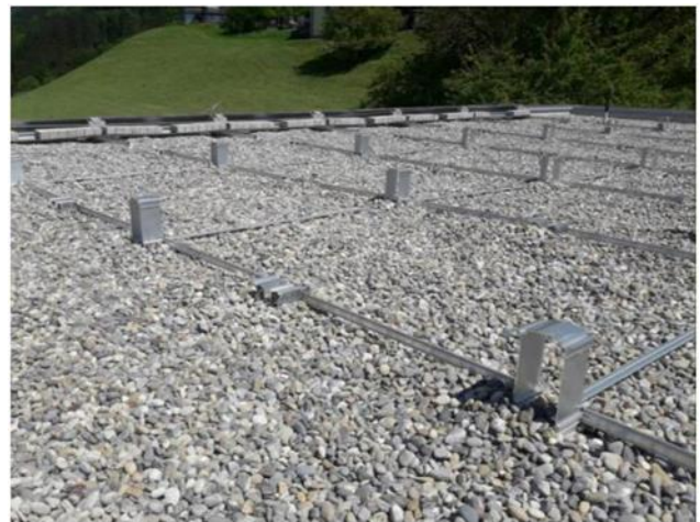
Image 8: Système de montage MSP-FR entièrement monté
