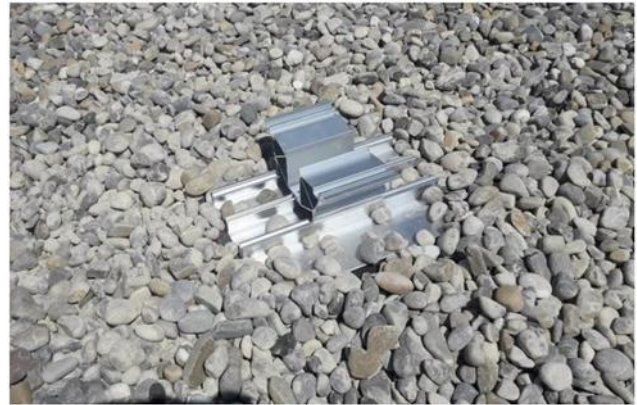
Image 6: Recouvrir légèrement la couche intermédiaire de gravier
