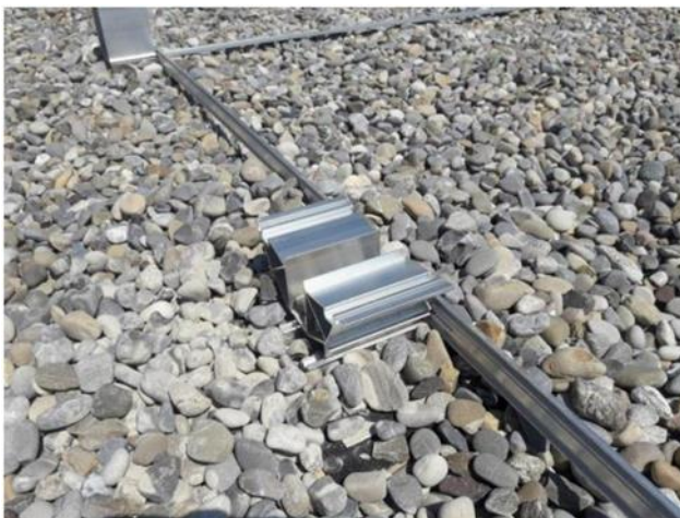
Bild 7: Stütze mit montierter Verbindungsschiene
