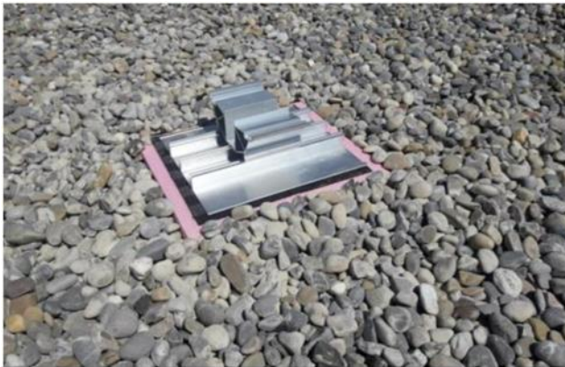
Bild 5: Platzierung der Basisplatte mit Stütze, Vlies unter der Basisplatte
