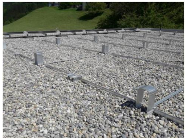
Bild 8: Montagesystem MSP-FR komplett montiert
