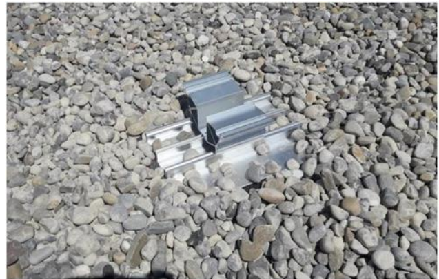
Bild 6: Leichte Überdeckung der Zwischenlage mit Kies
