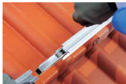
Werkzeuglose Montage des Schienenverbinders ohne Verschraubung.
