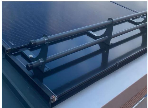
Le dispositif d'arrêt de neige doit être construit selon les instructions du fabricant et sa conception doit être vérifiée par un spécialiste.
