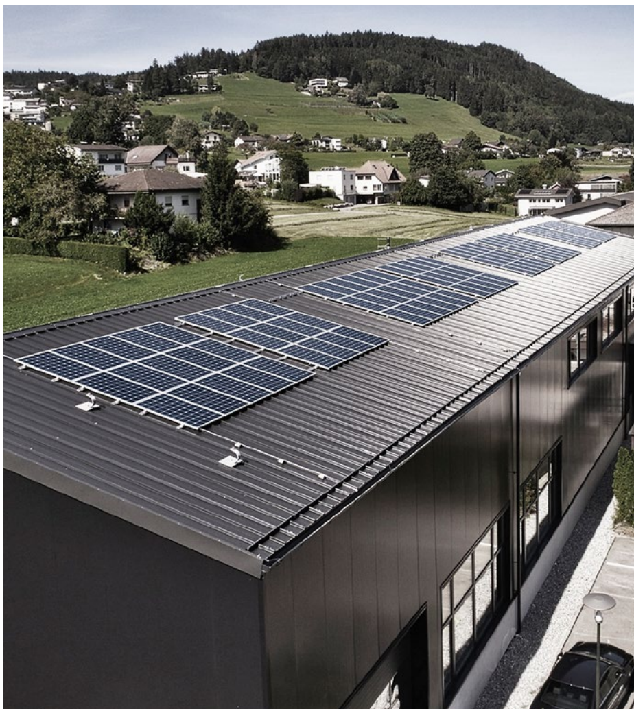
MSP-MR metal roof Göfis (Österreich)
